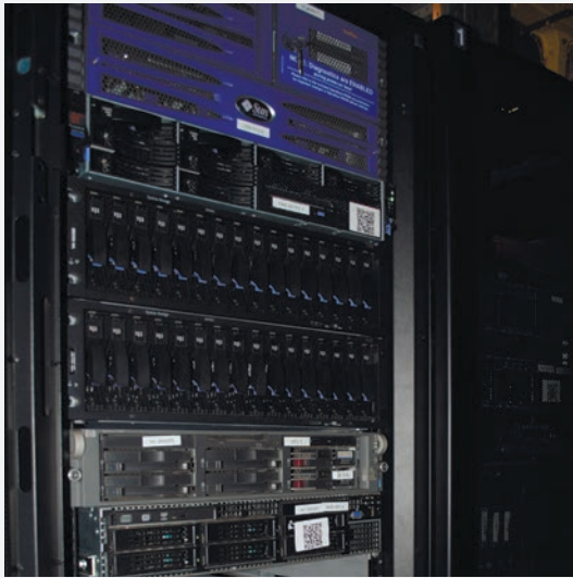
AMS-1000, серверы обработки трафика и система виртуализации и биллинга
