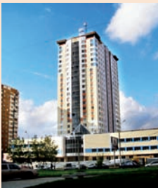
Название «Вертикаль» подмосковному «небоскребу» подходит
