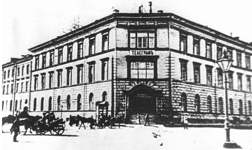
Московская центральная телеграфная станция на Мясницкой улице. Конец XIX века
